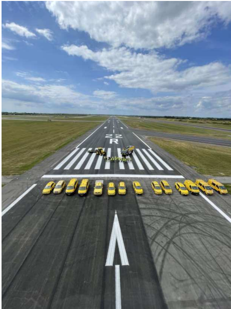
Figur 8: Ved banearbejdet på bane 04L/22R blev 90.000 m 2 belægning udskiftet på hovedbanen og de tilhørende rulleveje.
