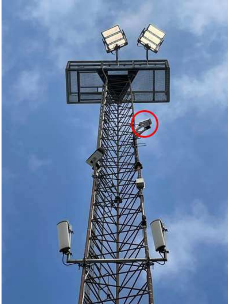
Figur 20: Mast 3 med A700 højt over standplads A21
